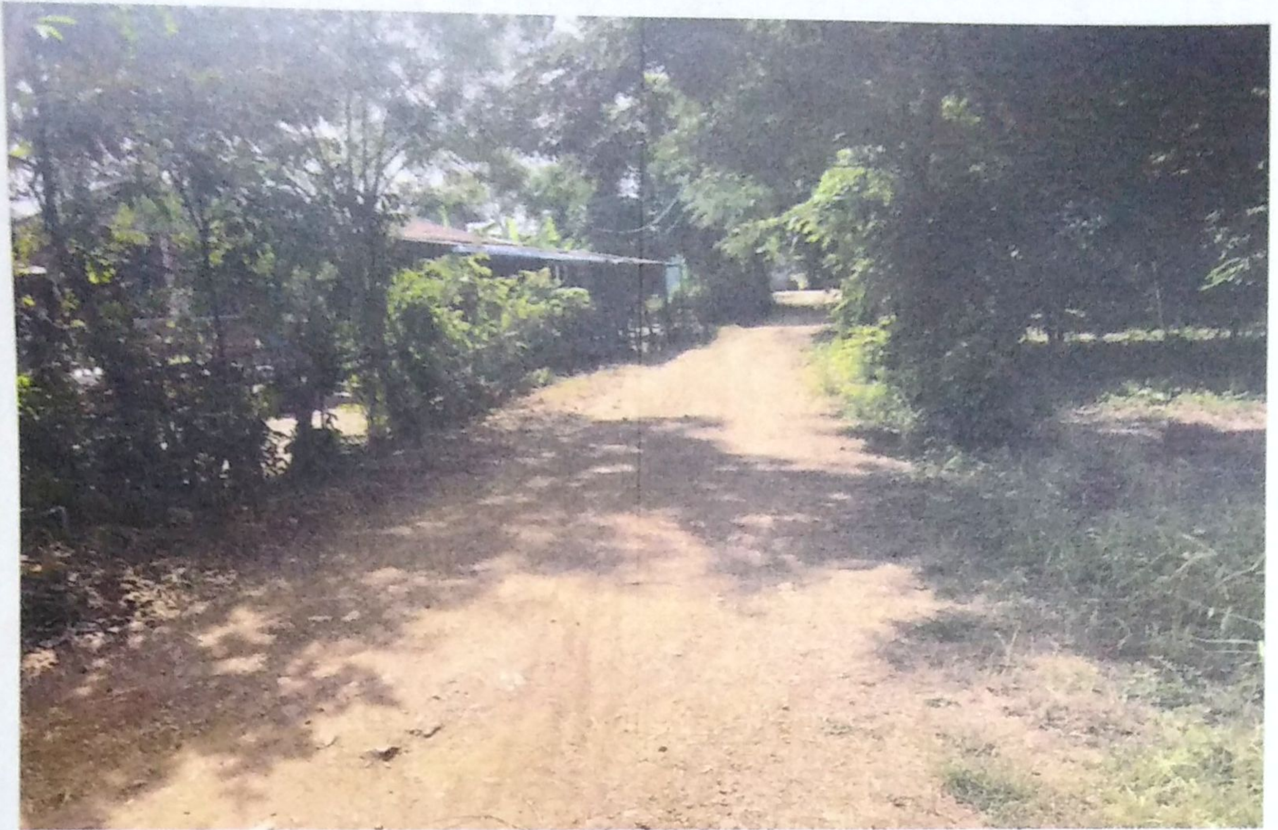
รูปถ่ายทำโครงการก่อสร้างถนน คสล. หมู่ที่ ๑๐ (สายบ้านนางสาคร ดีเกิด ) ต.น้ำซุน อ.หล่มสัก จ.เพชรบูรณ์
