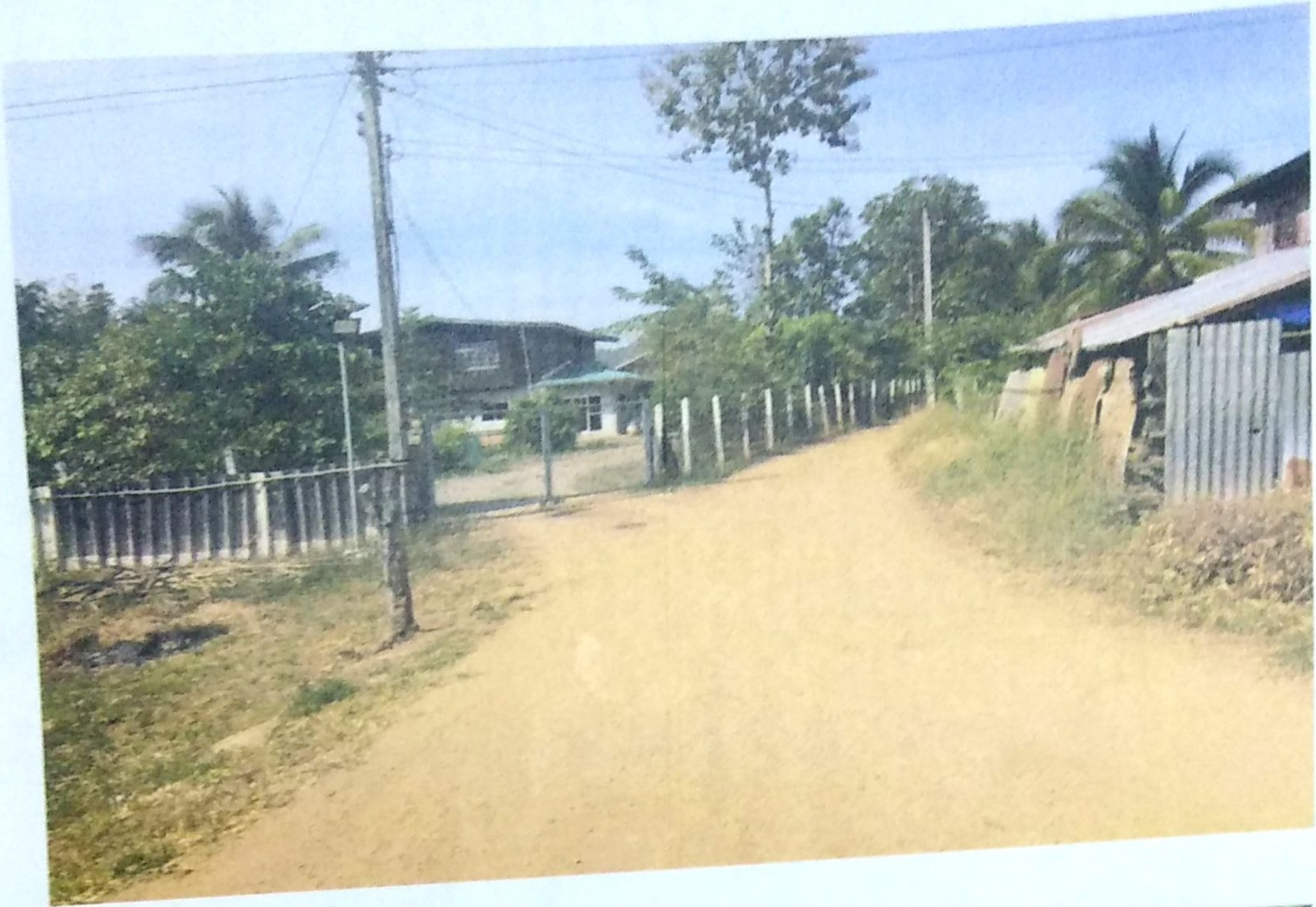
รูปถ่ายทำโครงการก่อสร้างถนน คสล. หมู่ที่ ๑๐ ( สายบ้านนายสงวน ) ต.น้ำซุน อ.หล่มสัก จ.เพชรบูรณ์
