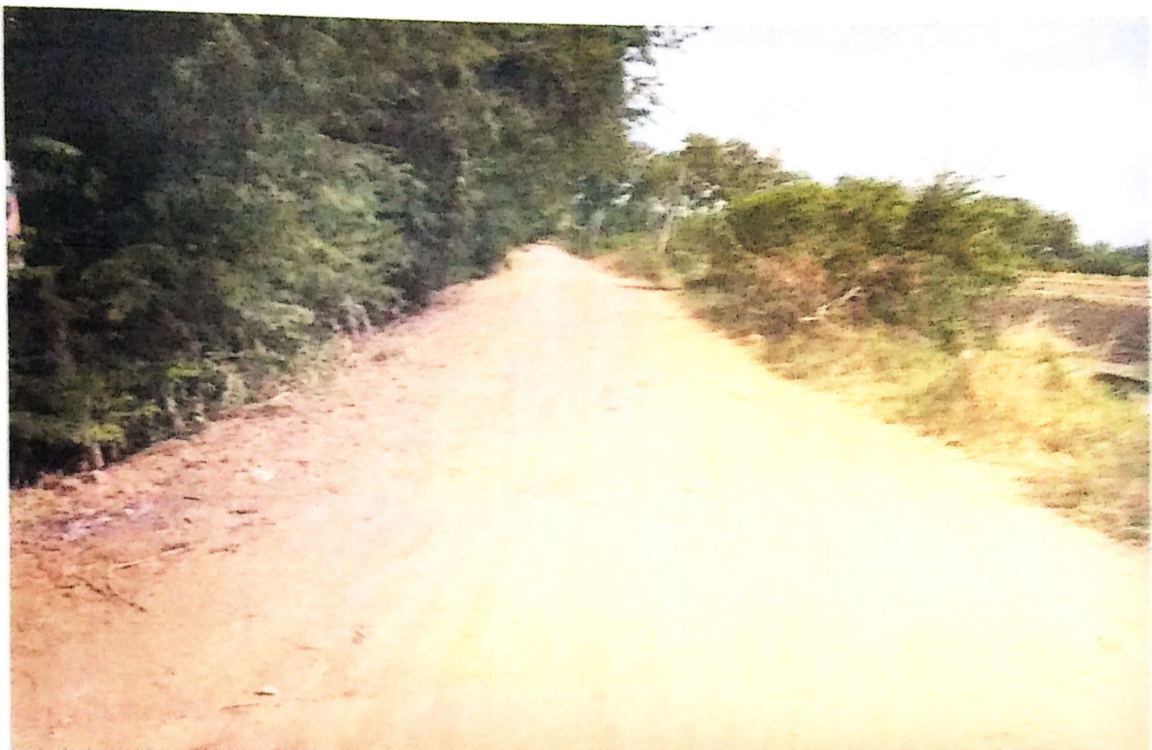
รูปถ่ายทำโครงการก่อสร้างถนน คสล. หมู่ที่ ๑๑ (สายบ้านนายสาธิต) ต.น้ำชุม อ.ห้วยสัก จ.เพชรบูรณ์
